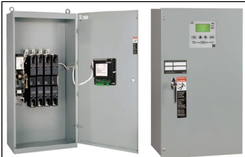
Figura 5. Imagen referencial Tablero de Transferencia Automático
