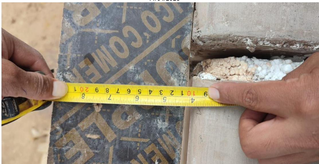
Fotografía N°02, desplazamiento transversal en la junta de aproximadamente 4mm, fecha de toma de fotografía: 11/04/2023
