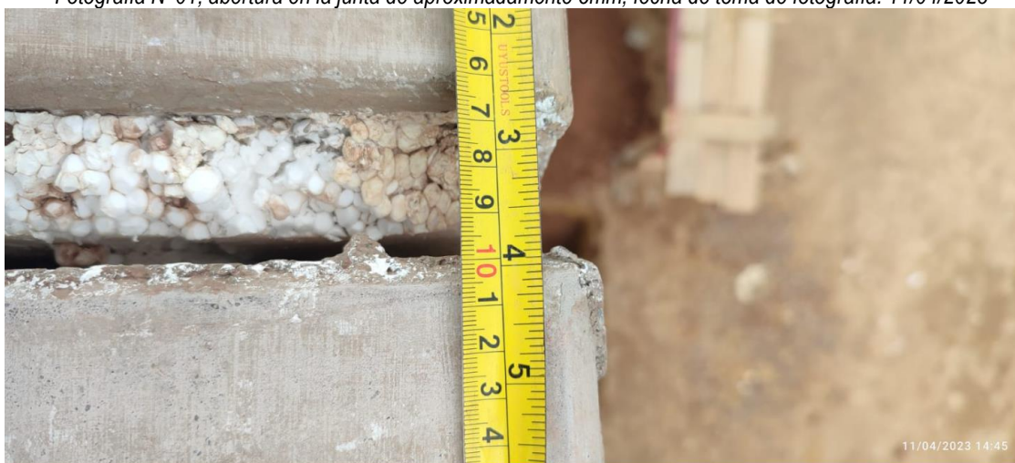
Fotografía N°02, desplazamiento transversal en la junta de aproximadamente 4mm, fecha de toma de fotografía: 11/04/2023
